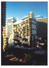
Z. 36. Controlled demolition eines großen Tanks (links) und eines Hochhauses (rechts). Die einzelnen Sprengsätze werden in exakt eingeplanter Zeitsequenz gezündet [24].
